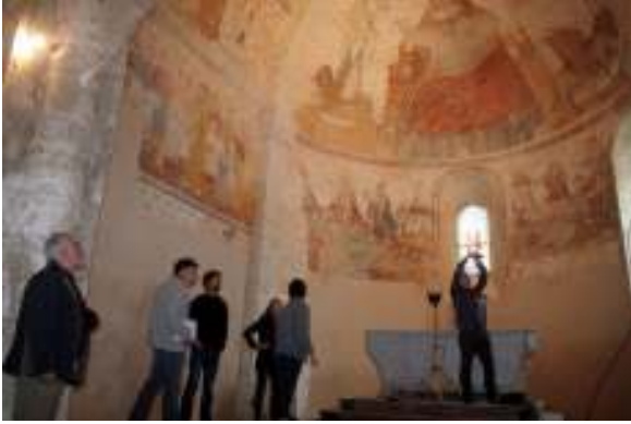
Vue partielle du chœur de l'église de Saint-Méard, pendant la réception des travaux. (Photo B. G.)
